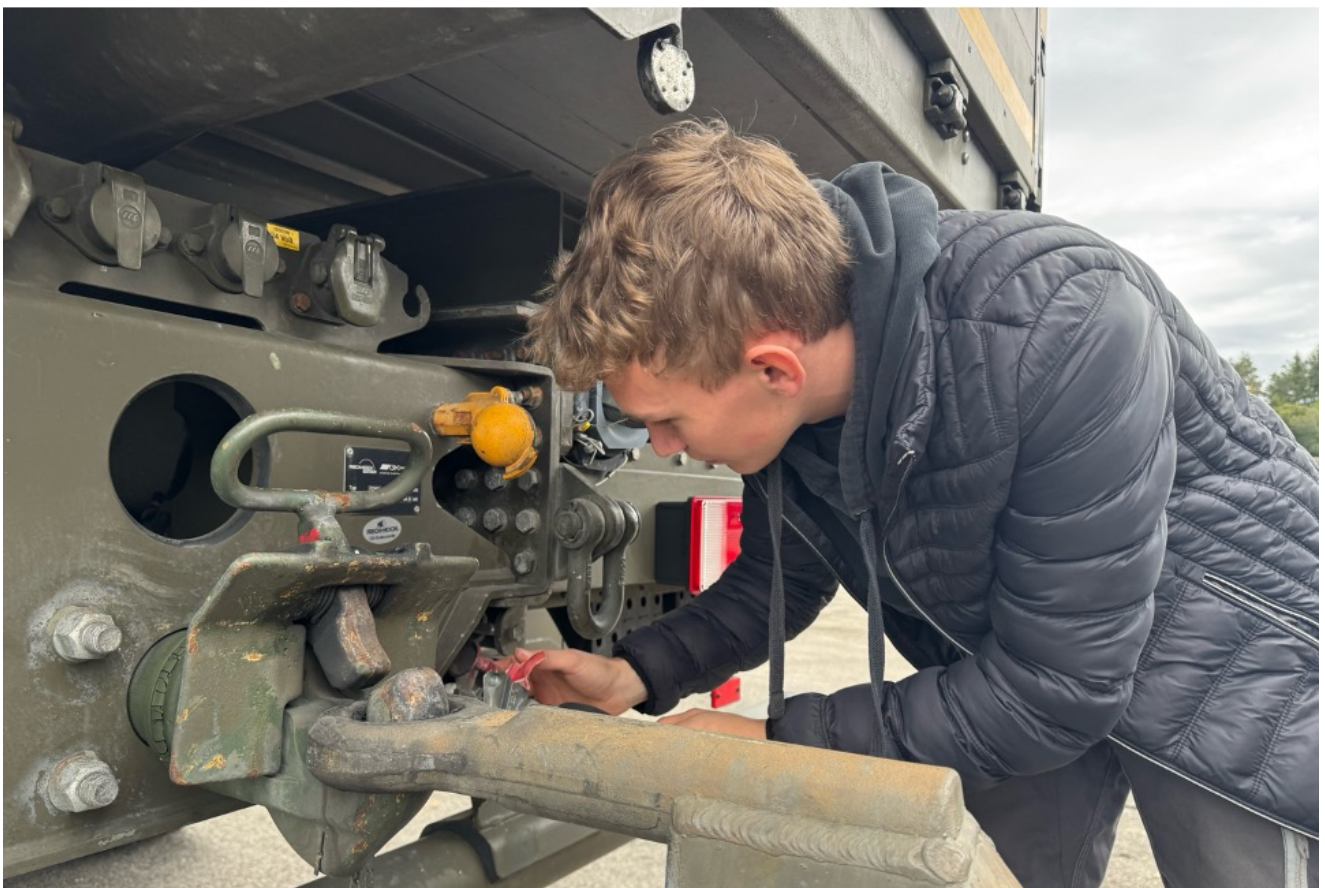
beim ersten Ankuppeln der Speiseleitung
