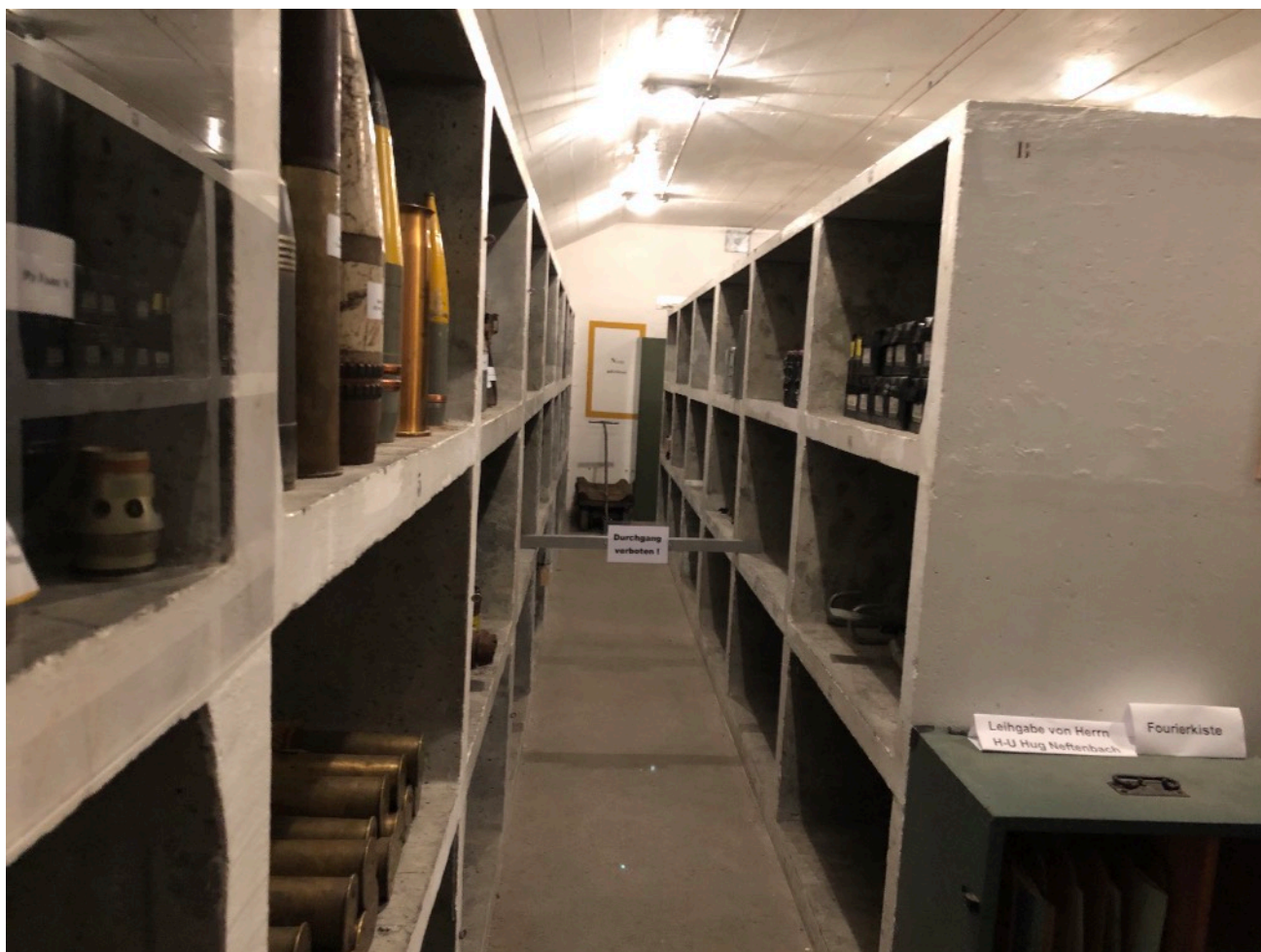
Munitionslager mit Aufbewahrungsfächer aus Beton (die anfänglichen Holzfächer hatte in der Anfangszeit zu schweren Unfällen geführt, weshalb diese durch Betonfächer ersetzt wurden)
